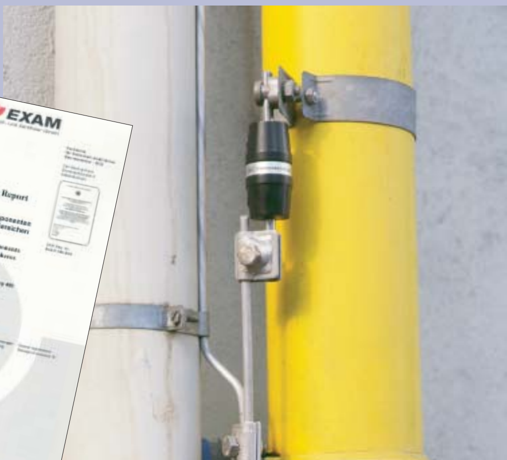
Рис.: Пример применения разделительного искрового разрядника типа 481
