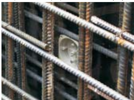
Крышка KBV прикрепленная на опалубку.
