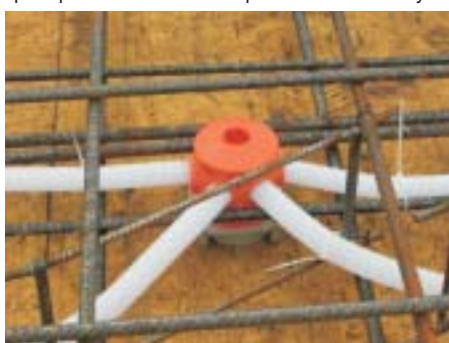
Пример использования в горизонтальной опалубке.
