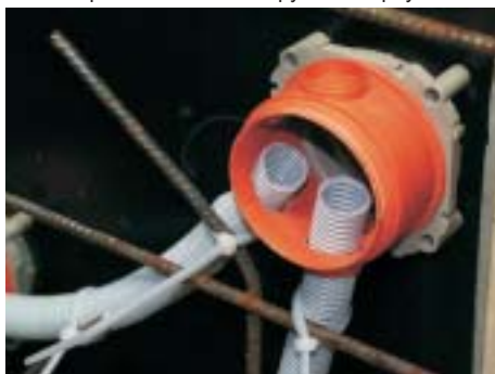
Смонтированные гибкие трубки в корпусе KBT.
