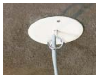
Коробка KBT... закрытая крышкой V 68 S с выведенным проводом и люстровым крюком KBP...
