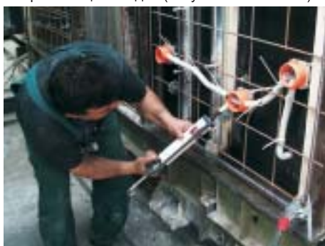
Герметизация вводов (битумная шпатлёвка).
