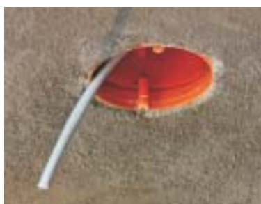
Коробка KBT... с выведенным проводом готовая для установки люстрового крюка KBP...
