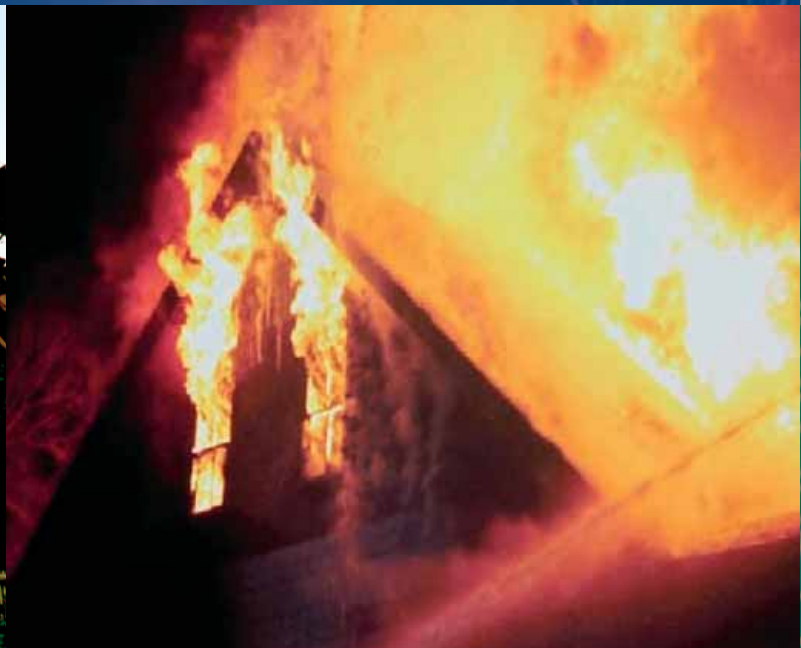
Пожежа в житловому будинку через влучання блискавки
