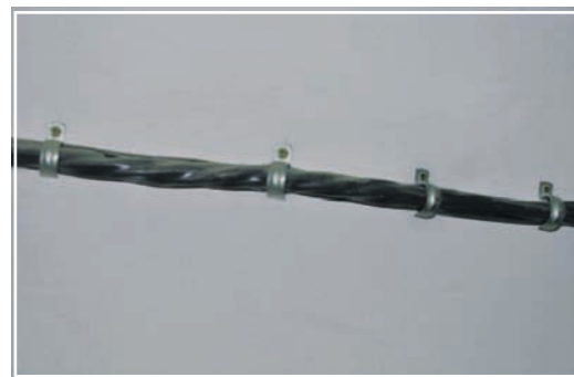
Монтаж кабеля при помощи скобы
